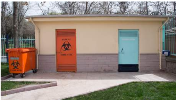
Şekil 13.7: Geçici atık deposu
