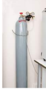
Şekil 8.12: Sıkıştırılmış gaz içeren tüplerin duvara sabitlenmesi
